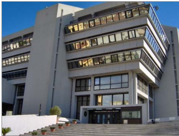
Palazzo Campanella - Reggio Calabria
